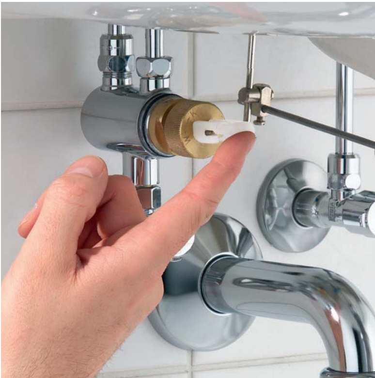
In waagrecht Position wird das Spülen ausgelöst.
